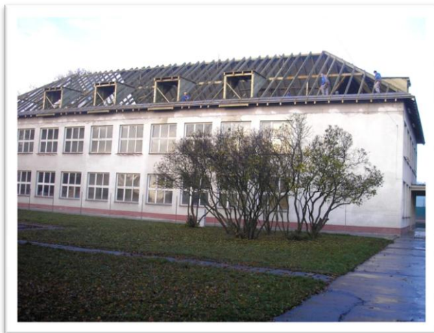
Obr. 18 Rekonštrukcia zadného A pavilónu
