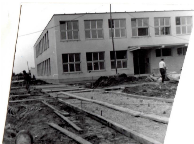
Obr. 7 Zo stavby školy
