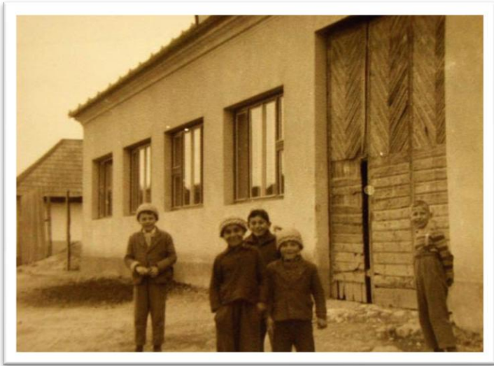
Obr. 4 Tretia školská budova pre Štátnu meštiansku školu v Korytnom, prerobená z budovy Miestneho národného výboru v Korytnom. Budova známa pod názvom Markusovec.
